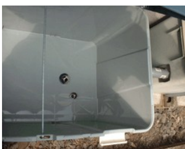
貯水槽設置 排水口は連結配管に接続
