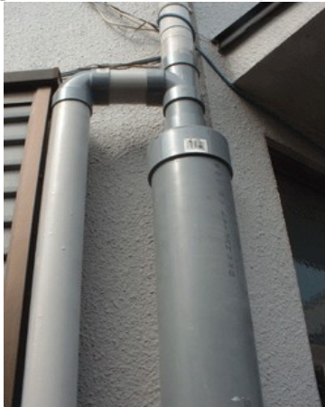
初期雨水分離装置上部配管状態 上部接続ソケットは下げられてT字ソケット内に落とし込んでいます。
