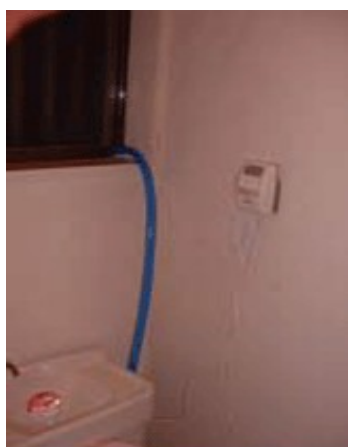
ホースの接続、手元スイッチの取り付け後のトイレです。
