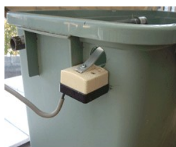
高架水槽にポンプ自動作動装置のスイッチを付けた状態。外に置く場合は防雨カバーを付けます。
