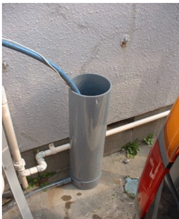
外部受水パイプにバスポンプを入れた状態です。下のホースは貯水槽連結パイプに接続しています。
